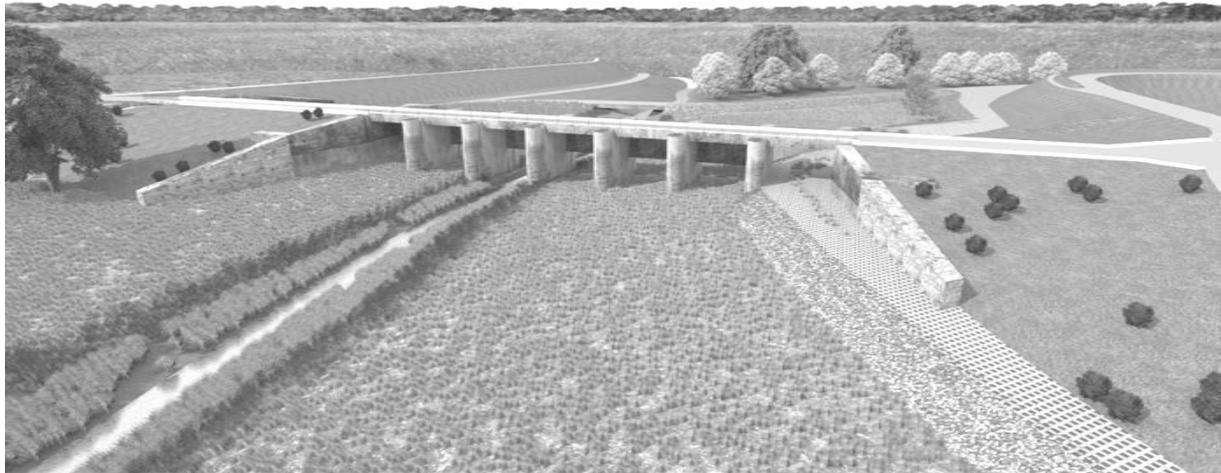
**Abbildung 2:** Visualisierung (M. Brückmann) eines ökologisch optimierten Absperrbauwerks mit angepassten Flügeldeichen, die eine Bepflanzung ermöglichen (vgl. Schmidt et al. 2011)
