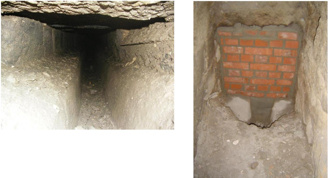
**Abbildung 8:** Altkanal an der Piatta forma im Zustand bei Suchschachtung (links, *DGC 2006*) sowie nach Verschließen des Kanals (*Scholz + Lewis 2007*)
