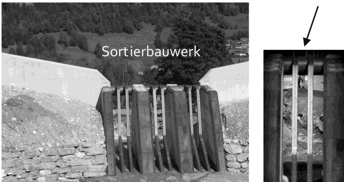
**Abbildung 5:** Sortierwerk mit Stahlrechenkonstruktion zur Geschiebebewirtschaftung
