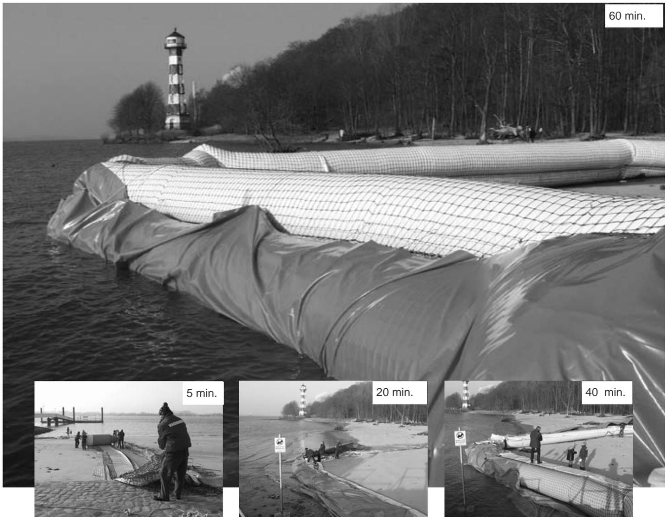
**Alle Vorteile auf einen Blick:** ▪ vollständig mobil: benötigt keine Fundamente ▪ hohe Standfestigkeit durch innovative Netzummantelung ▪ auf allen Untergründen einsetzbar ▪ in verschiedenen Ausführungen und Längen lieferbar - für Stauhöhen bis 2,60 Meter ▪ einfaches Handling – sehr schneller Auf- und Abbau mit nur wenigen Helfern ▪ kein Einsatz von schwerem Gerät
