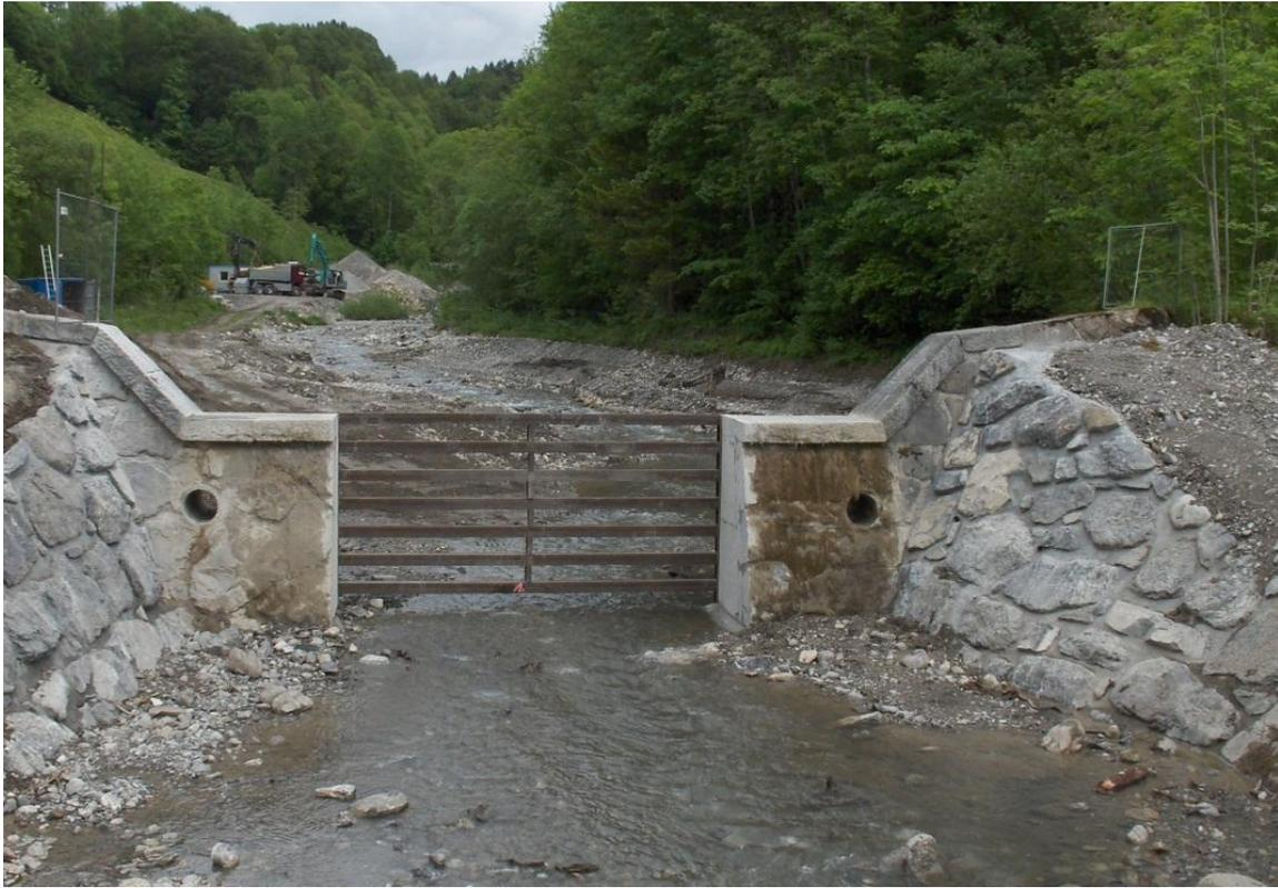
**Abbildung 4:** Umbau der Geschiebestausperre bei hm 38,00 in eine Balkensperre
